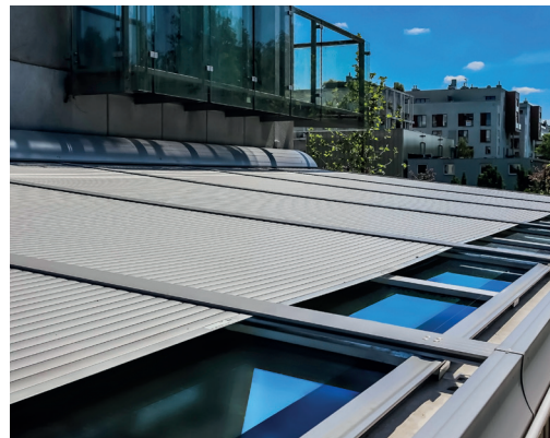
Relevé réalisé sous contrôle d'huissier
