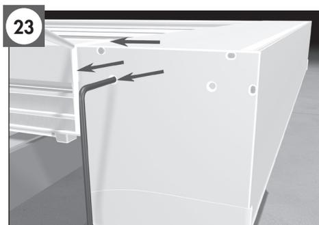
Réaliser l'étanchéité sur le côté, au passage de câble et au niveau du recouvrement avec un cordon de mastic silicone compatible (selon avis technique).
