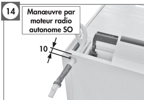
Percer le caisson **diamètre 6, puis diamètre 10** entre la joue et l'embout et insérer le câble du connecteur du panneau PV.
