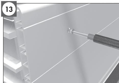
Fixer la sous-face **tous les 300 mm** dans le renfort de menuiserie avec vis TFB diamètre 4, longueur selon menuiserie.
