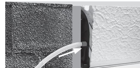
Casser l'opercule de la joue, passer la gaine et le câble d'alimentation, puis réaliser l'étanchéité à l'air de l'intérieur à l'aide de mastic.
