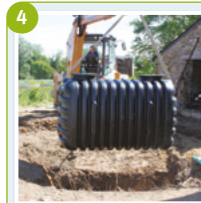
4 Réalisation de la fouille et mise en place de la fosse toutes eaux
