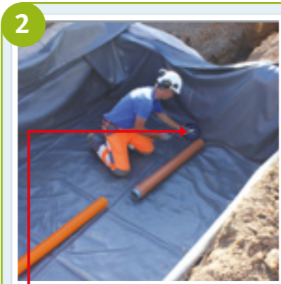
2 Mise en place de la membrane, du drain de collecte et du gravier drainant
