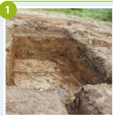
1 Réalisation de la fouille du filtre Biomatic selon le plan fourni
