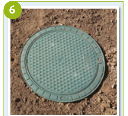
6 Remblaiement final (gravier 10/40) et ajustement des rehausses télescopiques
