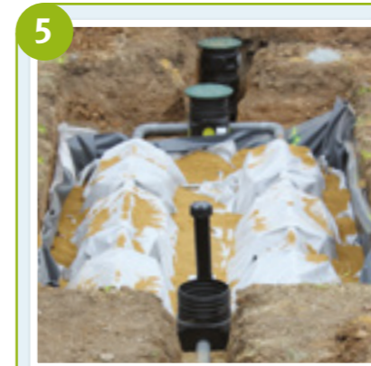
5 Mise en place de la chasse à auget, des regards, des drains d'épandage et raccordement à la fosse toutes eaux
