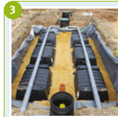
3 Mise en place du sable roulé lavé constituant le filtre à sable et des modules Biomatic
