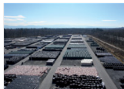
Plateforme de stockage
