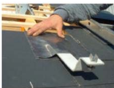
Figure 21 – Exemple de montage du kit de fixation pour 1 capteur horizontal sur toiture ardoise
