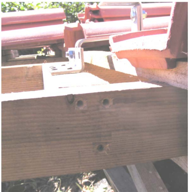
Fixation des ancrages sur chevêtre
