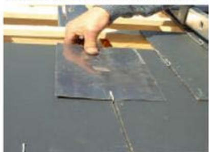
Figure 21 – Exemple de montage du kit de fixation pour 1 capteur horizontal sur toiture ardoise
