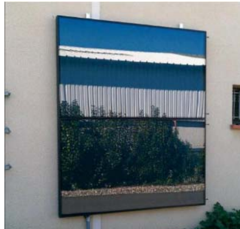
Figure 31 – Exemple de montage mural pour 2 capteurs horizontaux
