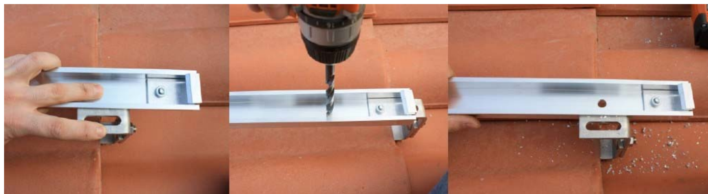
Fixation du châssis sur les pattes de fixation
