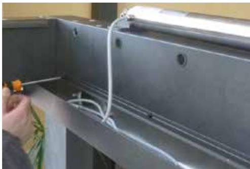
1. Vérifiez la position des gouttières adéquates avec l'ajustement de l'ordre des trous de dérivation dans les barres. Commencez l'installation des gouttières par les barres latérales (avec les trous pour les lames)
