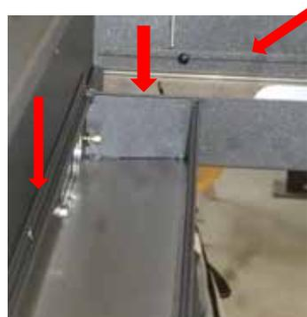
5. Mettez les gouttières aux barres frontales et arrières (existence en fonction de la variante de pergola) – en glissant entre les gouttières des barres latérales. N'oubliez pas de scellement préalable (point 2). Vissez-les selon les indices dans les point 2 et 3. Effectuez le scellement avec la silicone des lieux de liaison supérieure de la gouttière avec les gouttières voisines (fig. 17) et les trous ovales de trop-plein (fig. 16)
