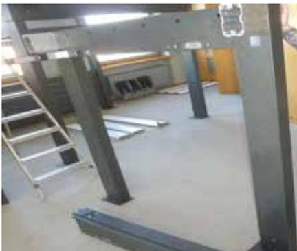
7. Assemblez la seconde barre avec les poteaux et vissez-les analogiquement au point 5. Sécurisez-les contre le basculement. (fig. 6)
