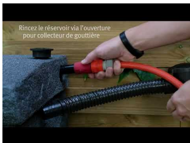
Comment nettoyer un réservoir aérien ne disposant pas d'un couvercle ?
