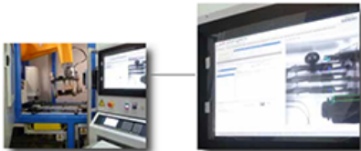
Contrôle de l'assemblage des composants aux rayons X : 4 à 7 clichés par moteur, 4 à 12 contrôles différents par cliché
