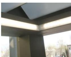
11. La position du connecteur du câble d'alimentation crée un angle mort dans le coin (fig. 9). Le phénomène peut être minimisé en déplaçant le connecteur du câble aussi loin que possible dans le coin.
