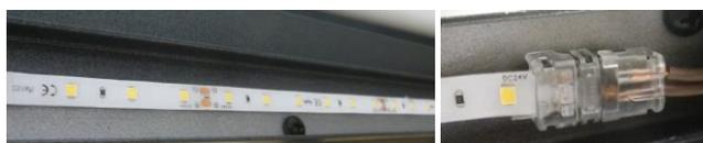
10. Appliquez le ruban LED dans le coin du côté du connecteur avec les câbles et collez-le au centre sur la bande d'aluminium (fig. 8).
