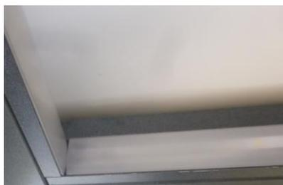
12. Mesurez, coupez et placez des couvercles (fausse baie) sur la bande d'aluminium (fig. 10). La fausse baie est livrée en longueurs de 2 m
